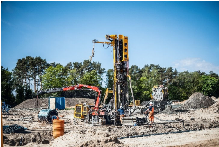
(1) BAUER Resources baut 135 Erdwärmesonden mit außergewöhnlicher Bohrtiefe von 170 m ein.
