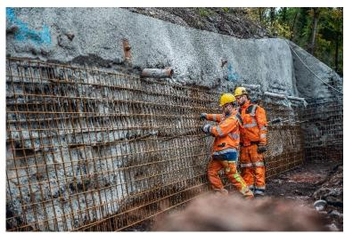
(3) Die eingebrachten Anker wurden mit Zementsuspension verfüllt und mit Bewehrungsmatten zusätzlich verstärkt.
