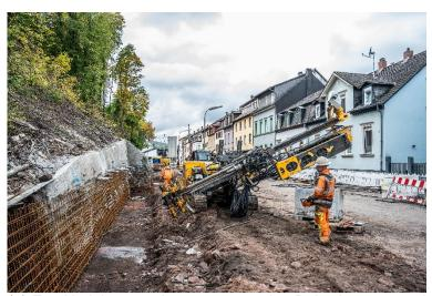
(2) Zur Absicherung des angrenzenden Bahndamms wurden 300 Verpressanker eingebracht.
