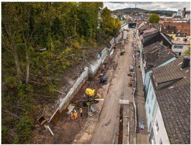
(1) Für den Ausbau der Trippstadter Straße in Kaiserslautern führte Spesa umfangreiche Hangsicherungs-Maßnahmen mit Rückbau und Bahndammsicherung aus.
